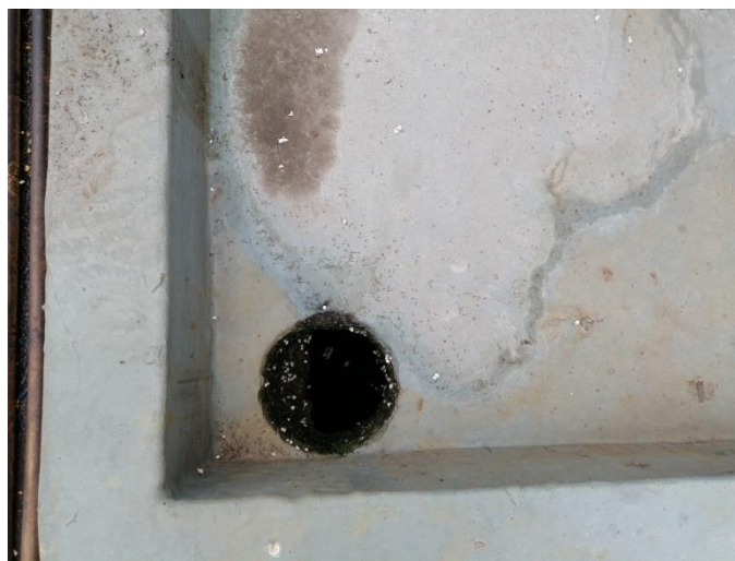
浓硫酸储罐区围堰与导流孔
