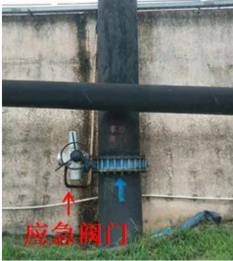
应急阀门（手动+电动操作）
