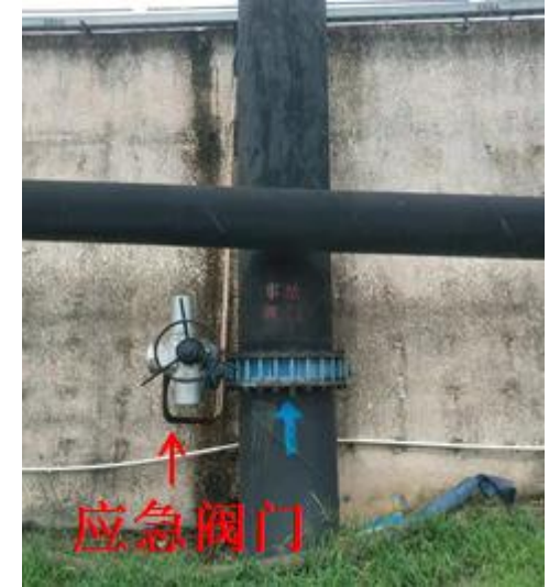
应急阀门（手动+电动操作）
