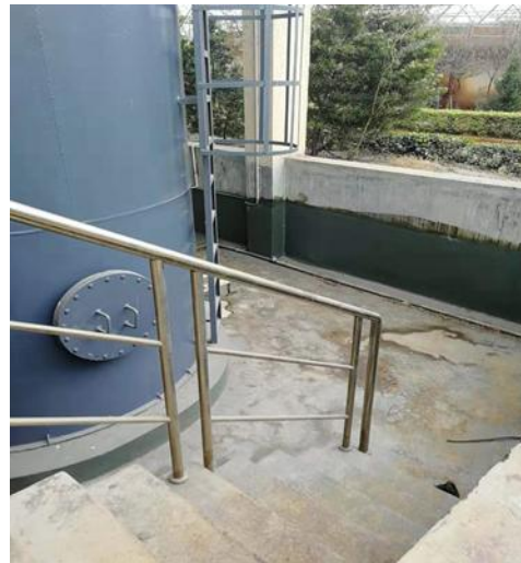
化学药剂储罐区防腐防渗玻璃纤维层-2
