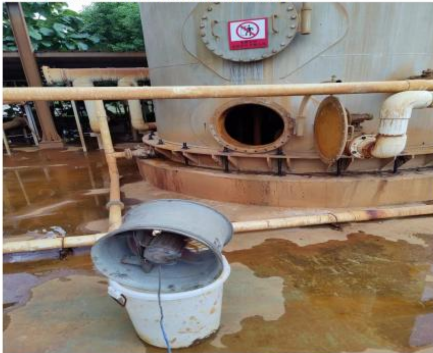
检修人员打开人孔通风，打开排气扇对内部空间进行通风排气
