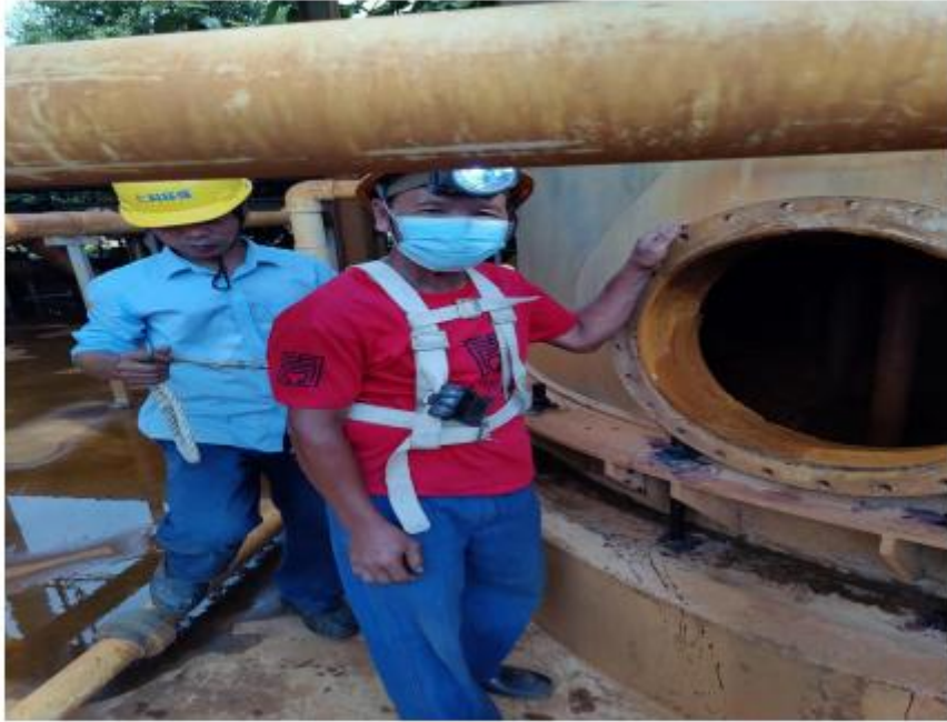
作业人员穿戴好安全帽、安全绳、气体检测仪等安全防护装备
