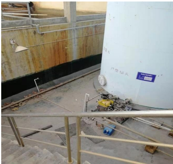
化学药剂储罐区防腐防渗玻璃纤维层-1
