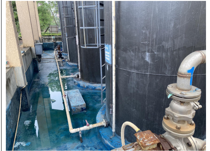
液碱储罐区围堰
