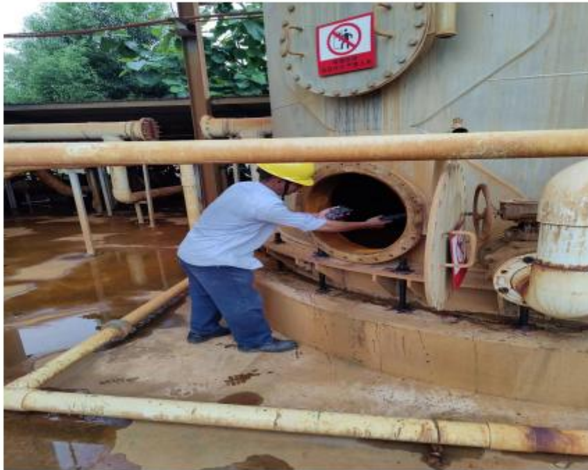
对人孔内部空间进行气体检测
