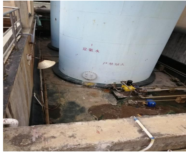
双氧水储罐区围堰
