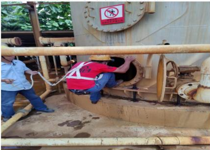
气体检测合格后，作业人员进行有限空间内进行作业，监护人员在人孔外进行监护，每隔 5 分钟询问作业人员身体状况是否良好
